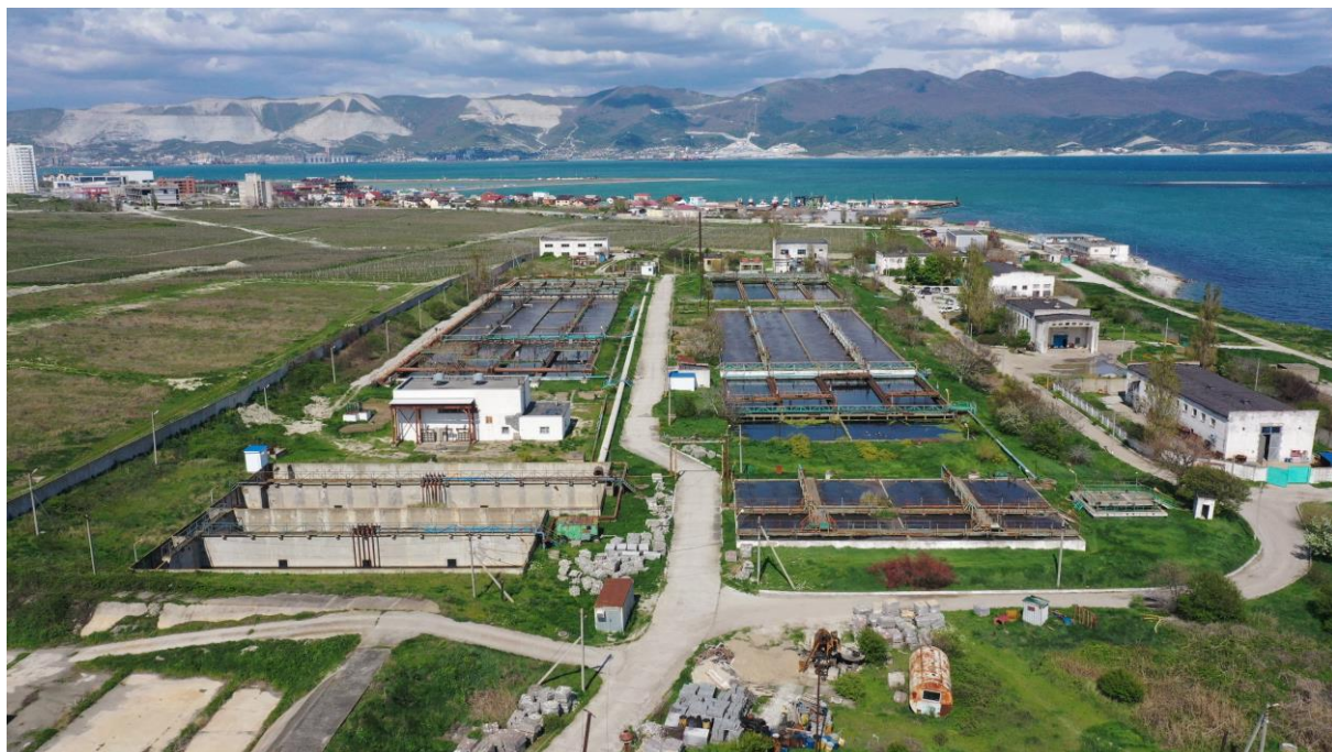
Рисунок. Применение квадрокоптеров при обследовании очистных сооружений
