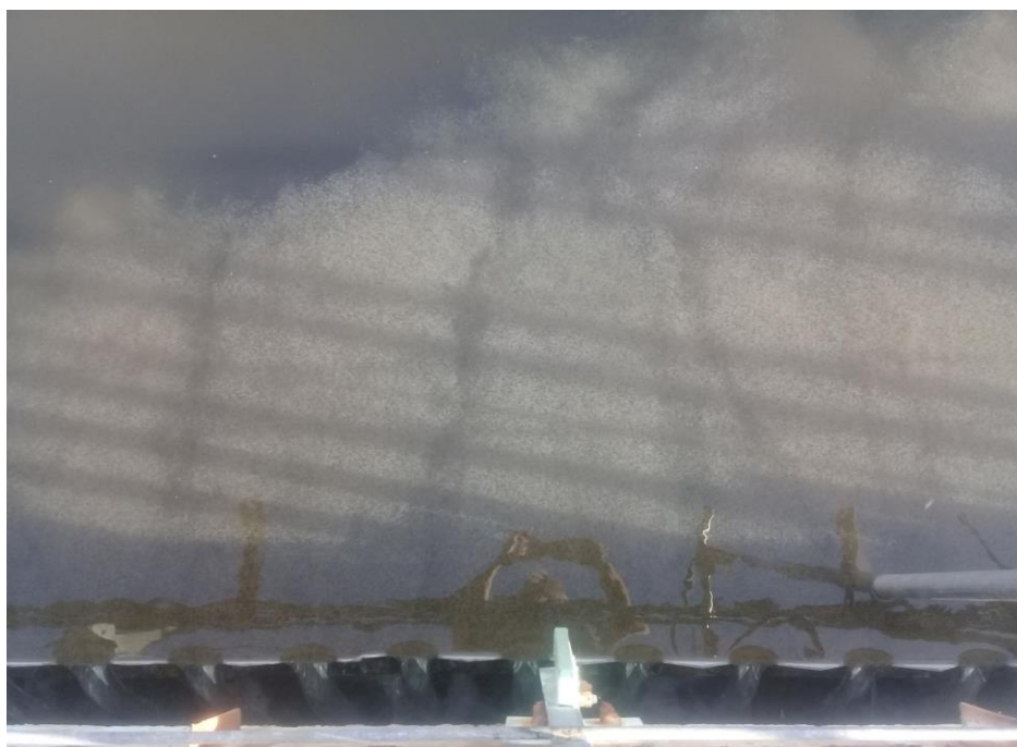
Фото 7. Всплытие хлопьев перед сливной гребенкой
