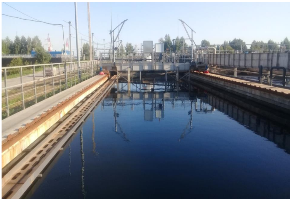
Фото 6. Горизонтальный вторичный отстойник с передвижным илососом
