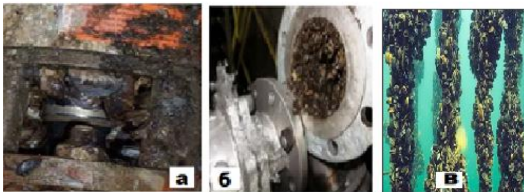
Рисунок 3. Разрушение дрейссеной: а) рабочих колёс погружного насоса; б) перекрытие водопроводов; в) перекрытие решёток
