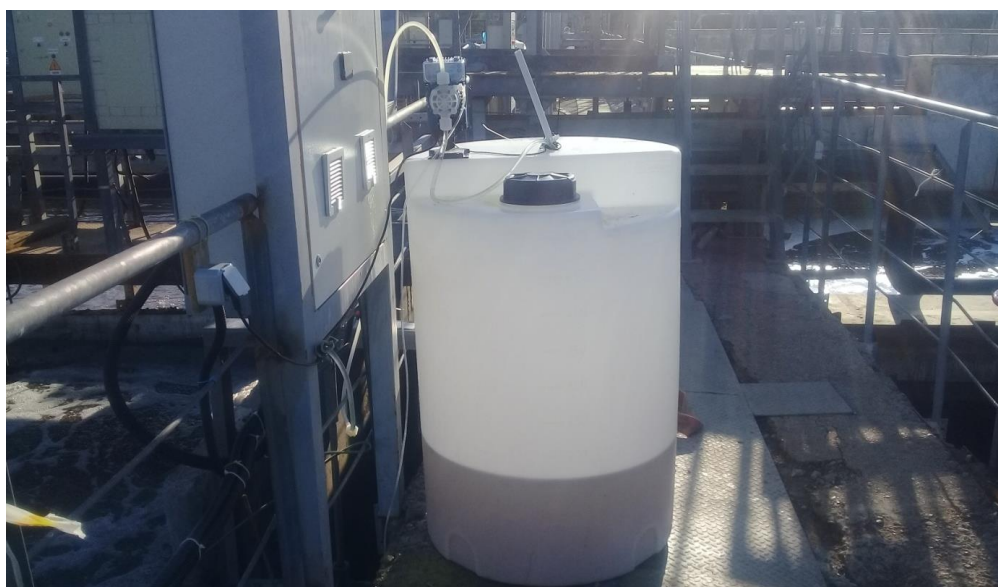
Фото 4. Емкость с коагулянтом и насосом дозатором
